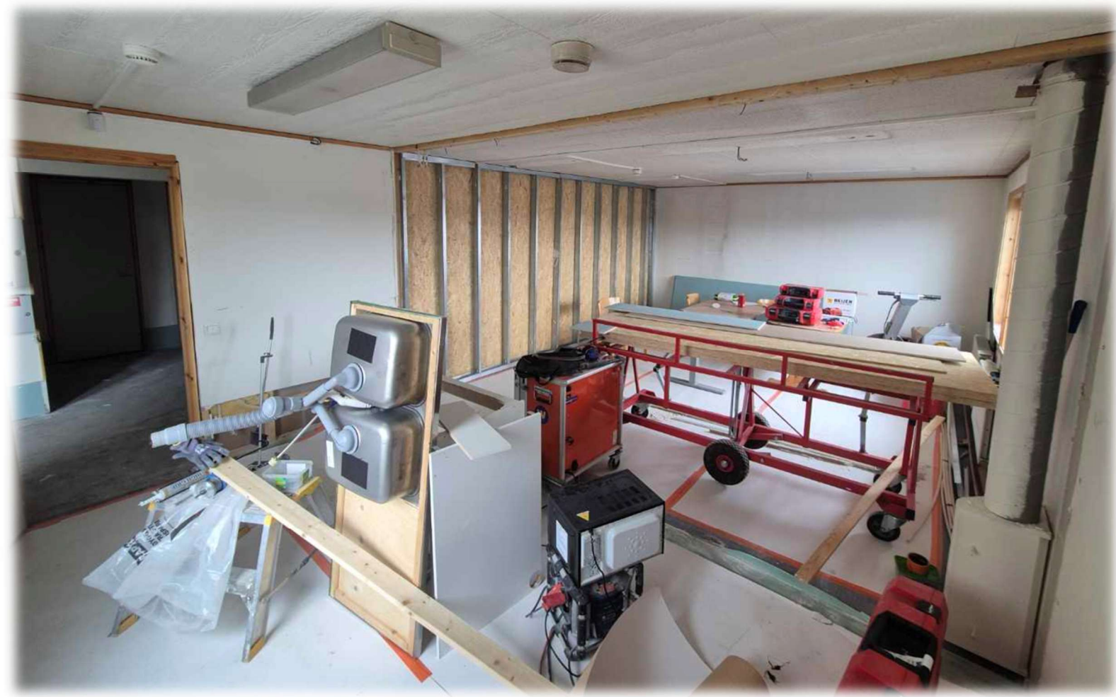
Pågående ombyggnation på Storliens brandstation
