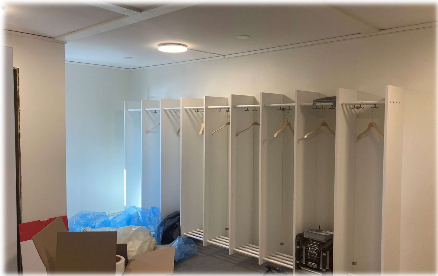
Pågående ombyggnation på Änge brandstation
